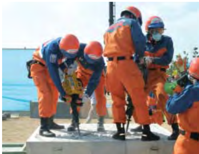
削岩機による掘削
